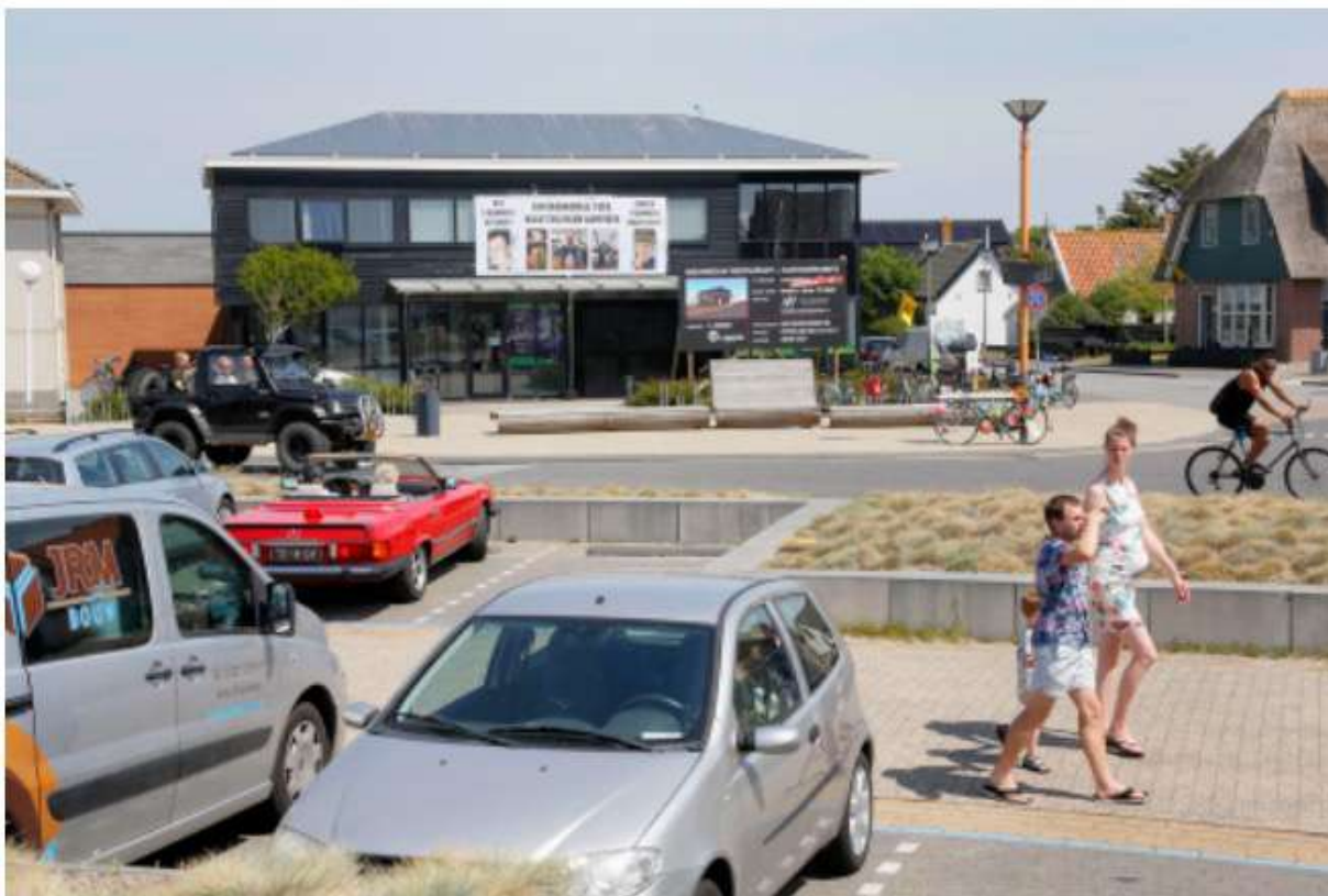
Het kantoorpand aan het Dorpsplein in Callantsoog wordt gesloopt en vervangen door nieuwbouw met op de begane grond een restaurant en op de eerste verdieping kantoren.
